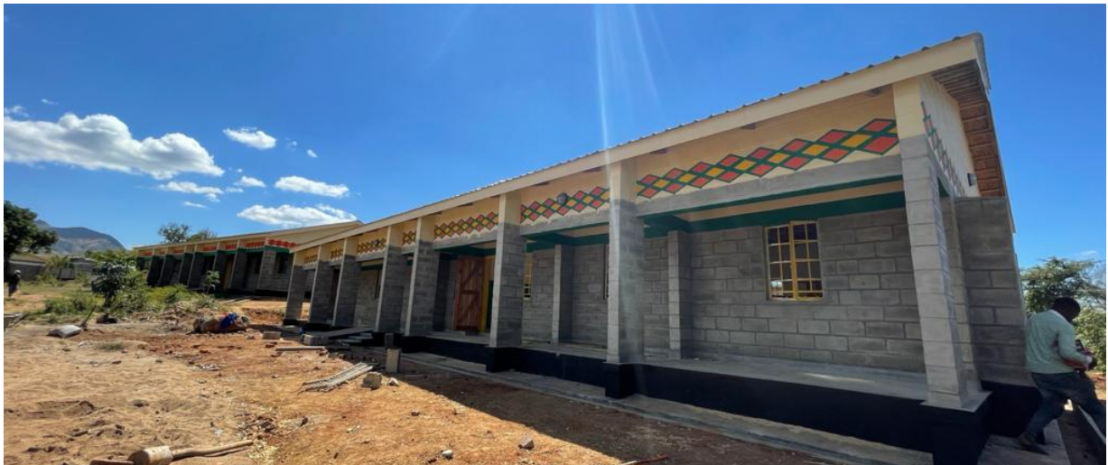
Frontansicht des Schulgebäudes
