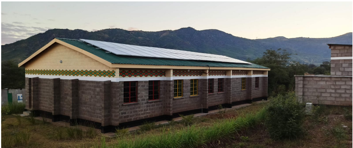
Rückansicht mit Solaranlage
